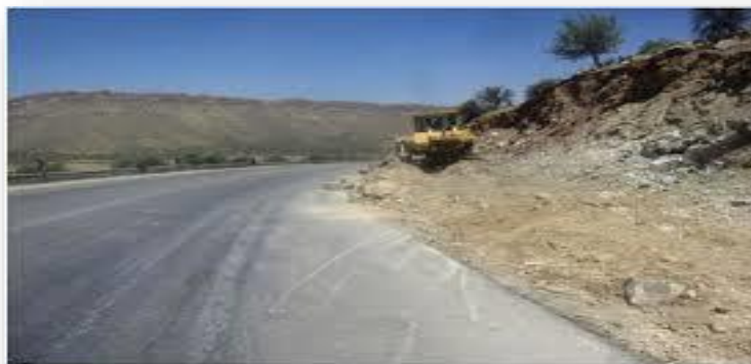
شکل 13: نقطه حادثه خیز بین روستایی بدون خط کشی، تابلو و روشنایی
